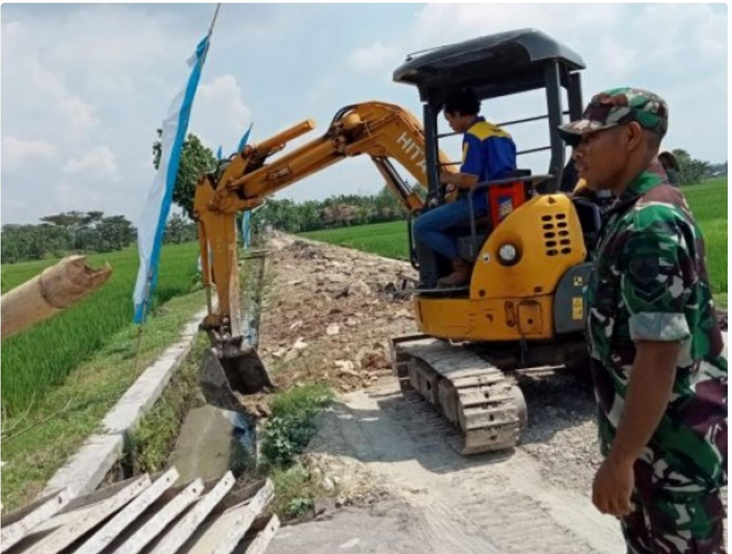
*Untuk mengoptimalkan target yang ingin dicapai di TMMD Reguler 113 Kodim 0723/Klaten mengerahkan dua alat berat berupa Excavator dan Bulldozer untuk meratakan dan mengeruk tanah yang berada di sasaran pokok jalan*
